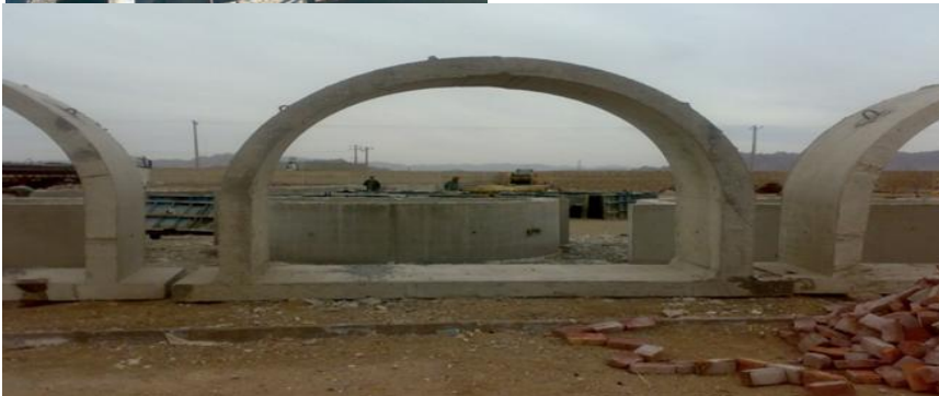
شکل ۲: رینگ‌های آماده شده زاغه متحرک
