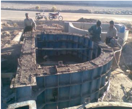
شکل ۱: یک عدد رینگ زاغه متحرک در حال ساخت.
